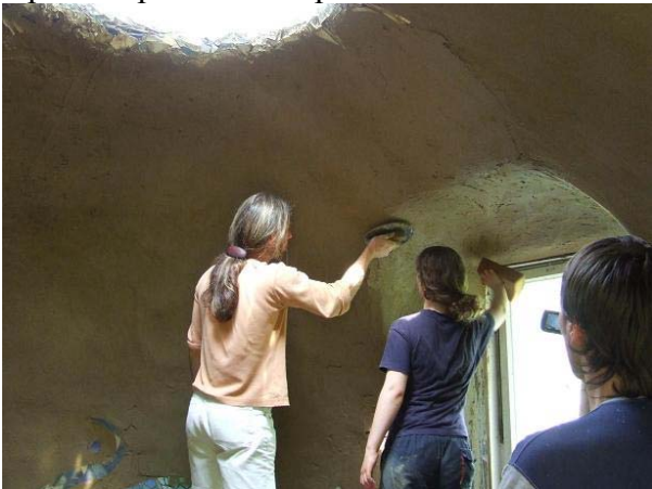
6 pav. Kupolo sienų tinkavimas moliniu tinku.
